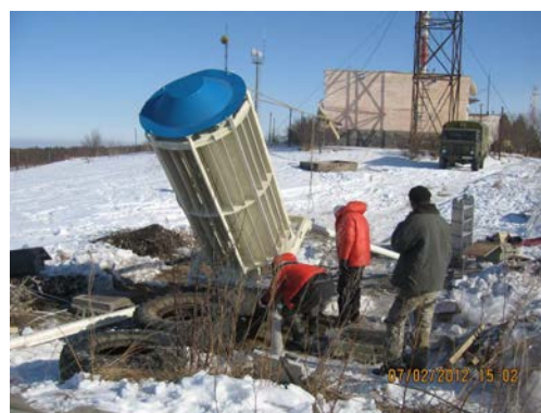
4. Подъем ветроэнергетической установки и монтирование оставшихся опор.
