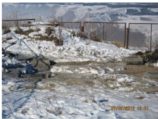
1. Подготавливается место под установку опор
