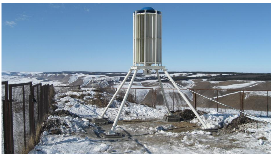
4. Подъем ветроэнергетической установки и монтирование оставшихся опор.
